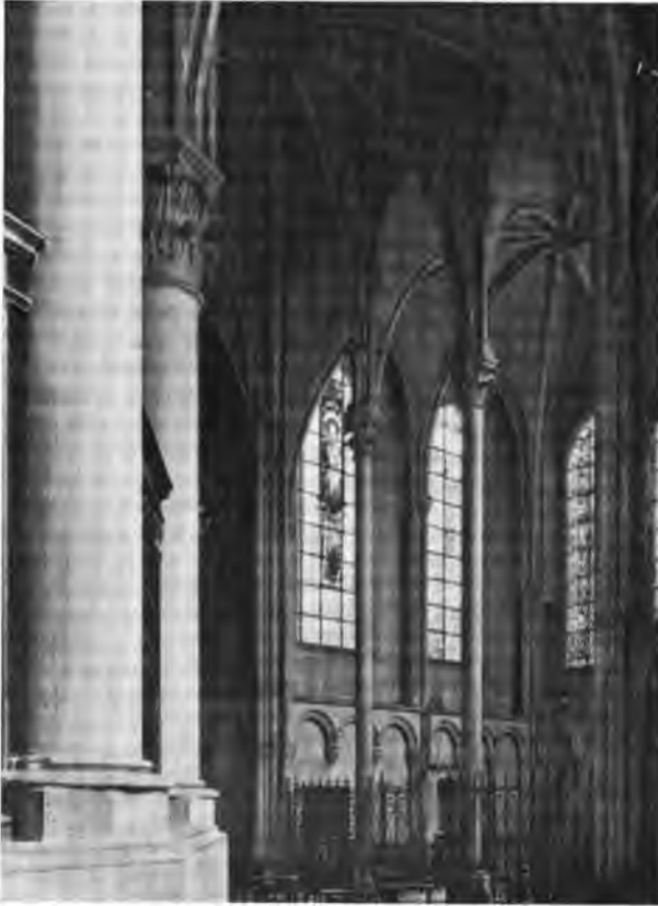
Fig. 155. - Colonnes monolithes facilitant le raccord des voûtes du déambulatoire avec celles de la chapelle absidale à la cathédrale d'Auxerre.
